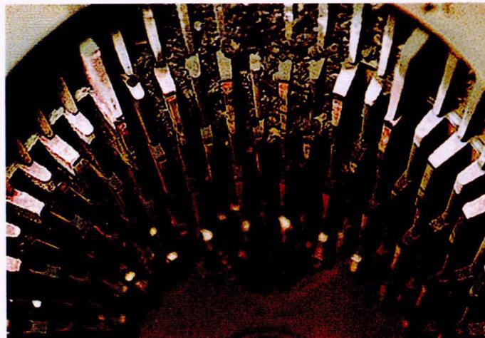
Feuerungsraum eines Heizkessels nach dem Einsatz nicht additivem Heizöl-EL.
